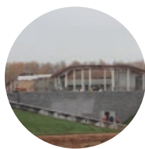
Электроснабжение ИЦ «Сколково»
